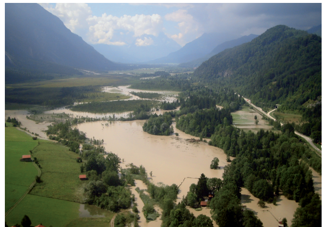
Abb. 1. Überflutung im bayerischen Voralpenland, August 2005. [Photo THW].
